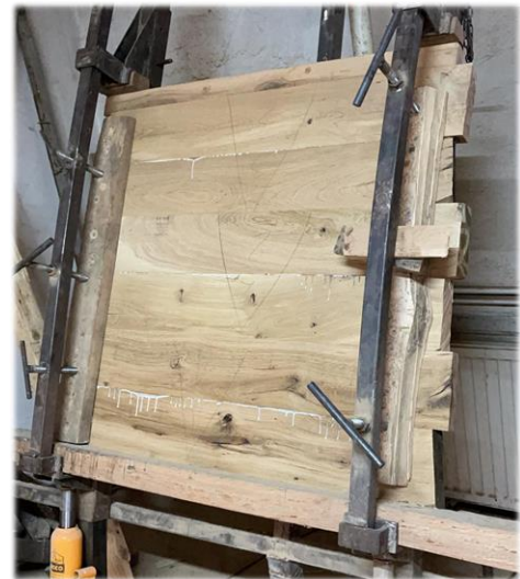
Verleimung mehrerer Treppenstufen
